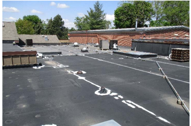
A-16: EPDM Roofing
